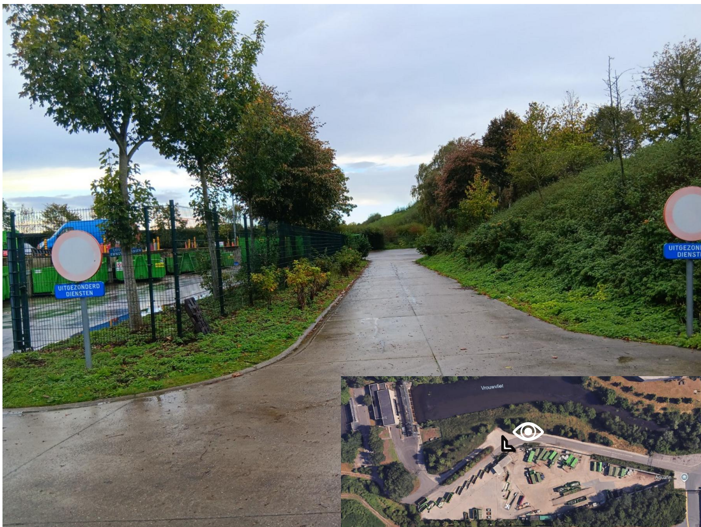
Figuur 2-1: Foto van het projectgebied. Links: groenscherm met 8 niet-hoogstammige bomen en recyclagepark. Rechts: berg met verontreinigde grond. Op de locatie waar de foto is getrokken, zal ongeveer de helling beginnen van de permanente toegangsweg naar het werkplatform en de windturbine.
