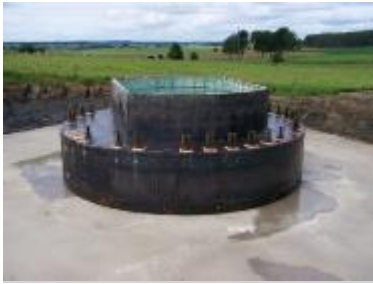
Figuur 5-9: Gewone (ondergrondse) fundering.
